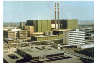
パクシュ原子力発電所原子力発電所外観
